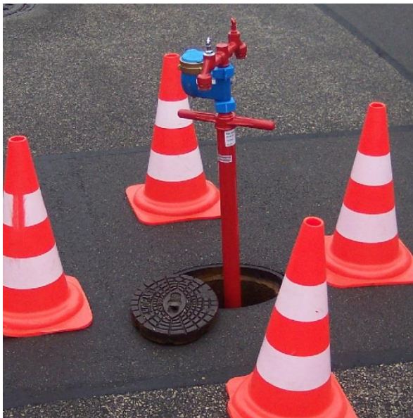
Bild 1. Standrohr mit Zähler für Unterflurhydranten
