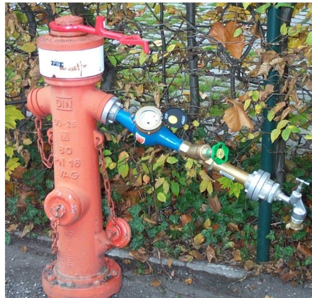
Bild 2. Hydrantenzähler für Oberflurhydranten
